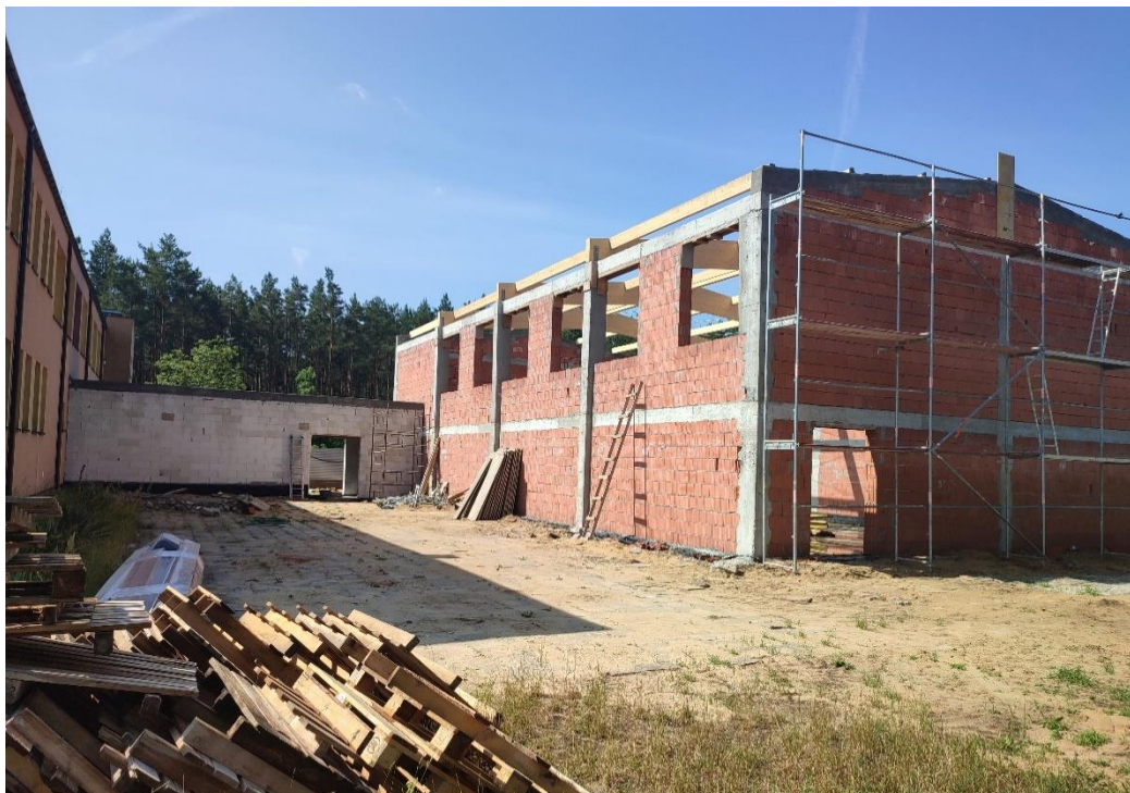
Zdjęcie 15. Trwają prace przy budowie Sali gimnastycznej w Górnikach.
