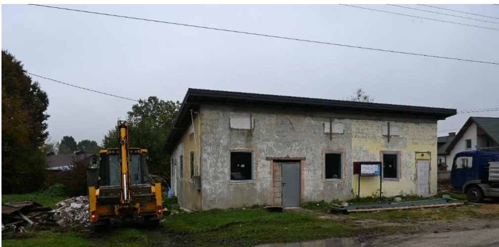
Zdjęcie 11. Przebudowa budynku w Pakułach i dostosowanie do działalności świetlicy.
