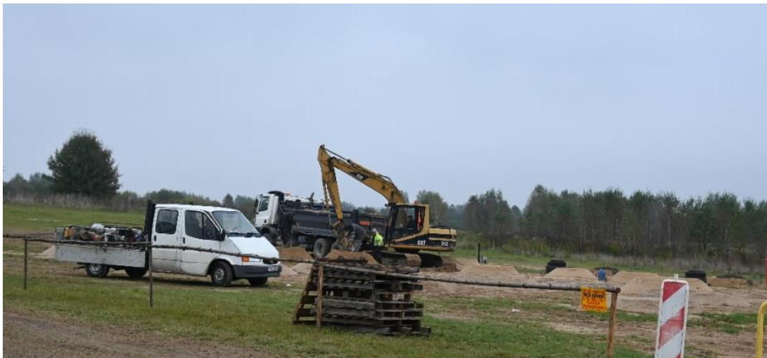
Zdjęcie 16. Prace przy budowie kanalizacji na terenie zalewu „Antoniów”.
