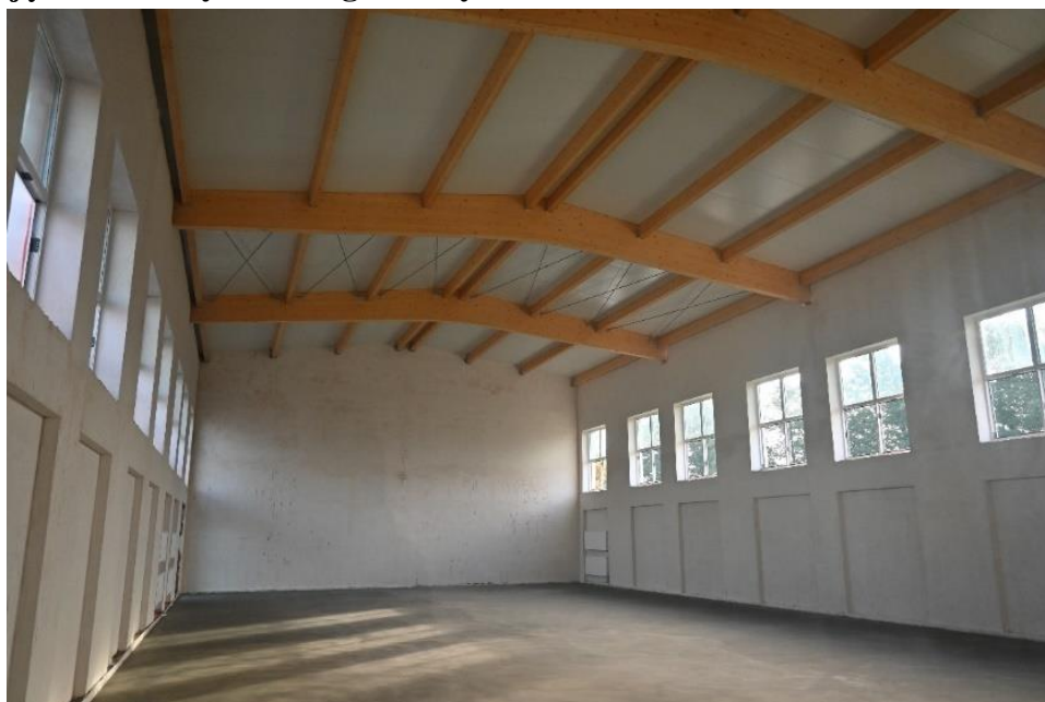
Zdjęcie 14. Budynek sali gimnastyczne w Wilczkowicach w trakcie budowy.
