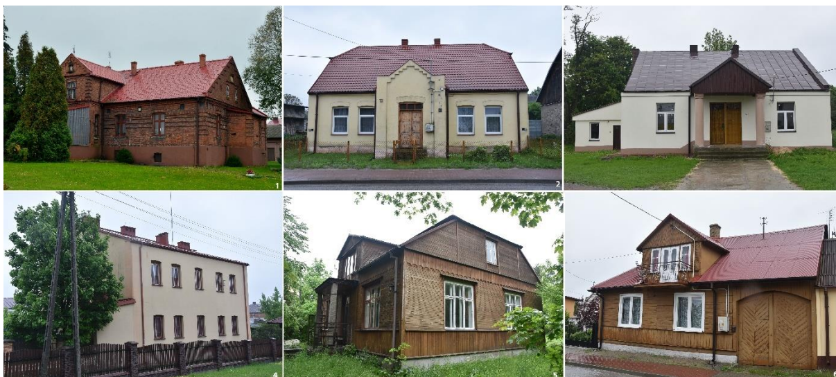
Fot. 6. Radoszyce. Budynki mieszkalne. 1) plebania, ul. 1 Maja 1; 2) ul. Konecka 12; 3) ul. Kościelna 11; 4) dawna „Rabinówka”, ul. Ogrodowa 19; 5) ul. Mickiewicza 7; 6) ul. Spółdzielcza 14 (źródło: Gminna Ewidencja Zabytków).
