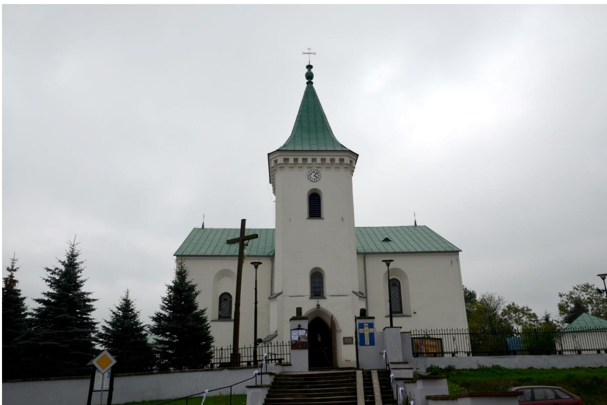
Fot. 1. Radoszyce. Kościół parafialny pw. Św. Piotra i Pawła (źródło: Gminna Ewidencja Zabytków).
