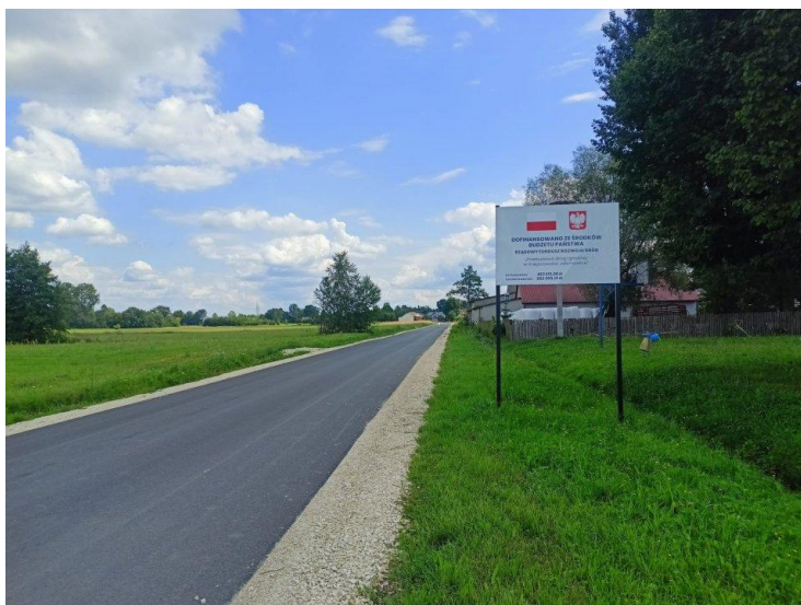
Zdjęcie 13. Przebudowana droga gminna w Jakimowicach
