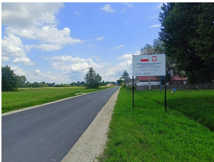
Zdjęcie 13. Przebudowana droga gminna w Jakimowicach
