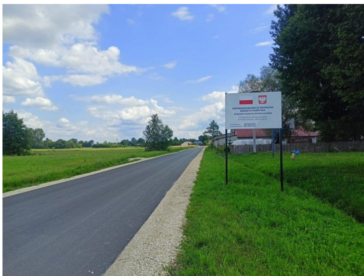
Zdjęcie 15. Przebudowana droga gminna w Jakimowicach
